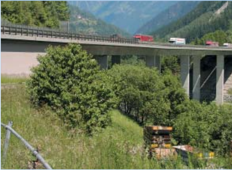
Pont sur la Reuss
