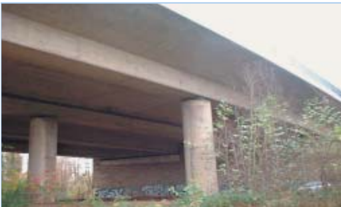
Vue partielle du Pont Konrad Adenauer
