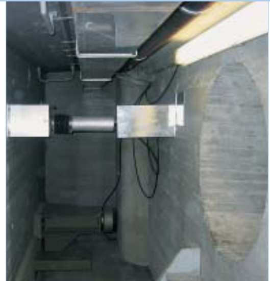
Suivi du joint de dilatation par EX-Large
