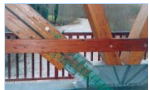
Détail d'une protection respectant l'esthétique de l'ouvrage
