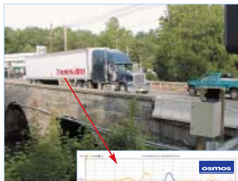
Déformation caractéristique de l'ouvrage sous chargement test
