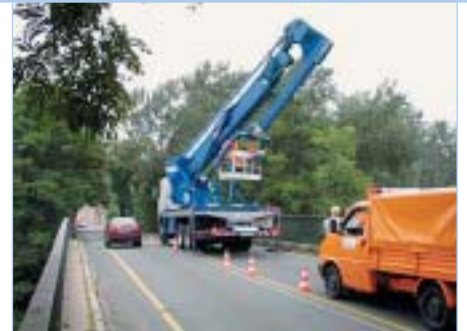
Installation par nacelle articulée en une journée
