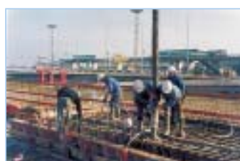
Coulage de béton sur la section équipée de cordes optiques
