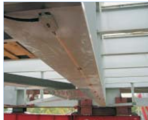
Corde optique en sous-face d'une poutre
