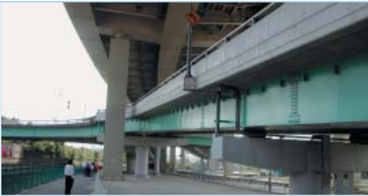
Sous face du tablier du pont de Honmoku
