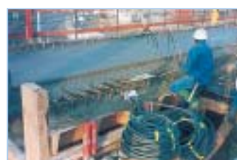
Après bétonnage, les câbles optiques de connexion protégés par gaine nervurée sont en attente d'être déployés vers la station de monitoring
