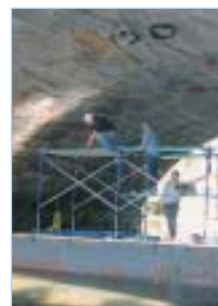
Installation des cordes optiques par ponton flottant
