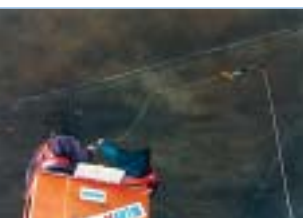
Pose d'une Corde Optique par nacelle
