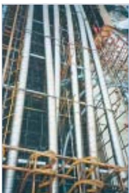
Unités de précontrainte et de leurs conduits avant le bétonnage
