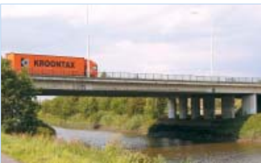
Le pont de Heusden, près de Gand, est un pont dalle sur poutre
