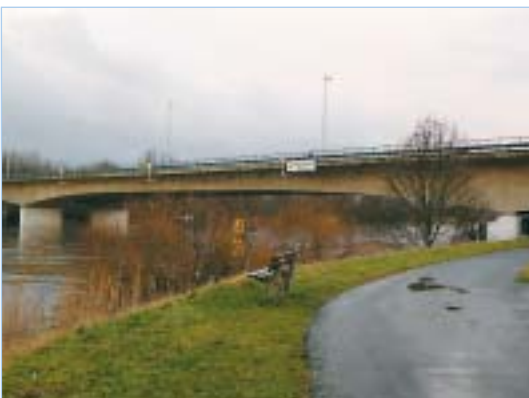
Le pont de Vlassenbroek, près d'Anvers, est un pont à voussoir
