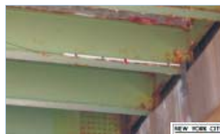
Corde Optique sous une des longrines du tablier
