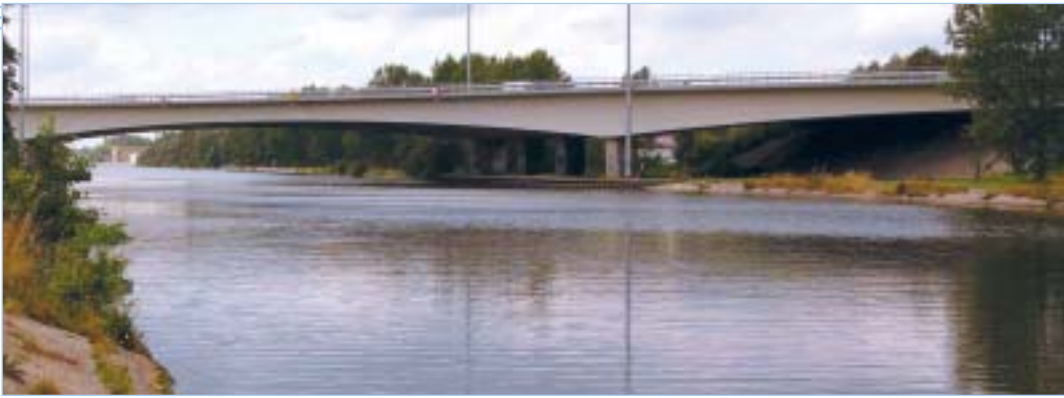
Le pont de Stasegem, près de Gand, est également un pont à voussoir
