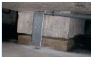
Exemple de capteur WIMS, ici posé sur le pont de Heusden
