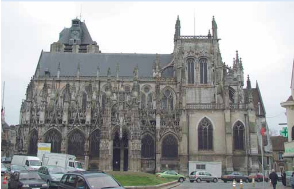
C'est par la volonté commune de l'Etat, du Département et de la Ville que l'Eglise classée, Notre Dame de Louviers bénéficie d'une restauration profonde
