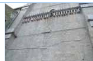
Vue nord du clocher et extensomètre optique sous protection
