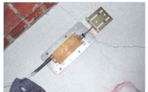
Avant le démarrage des travaux, les extensomètres et palpeurs optiques ont été installés à l'intérieur et à l'extérieur de l'édifice
