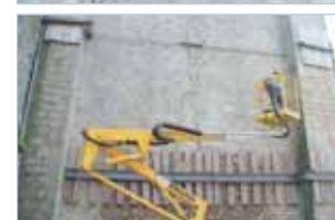
Installation en une journée par nacelle élévatrice
