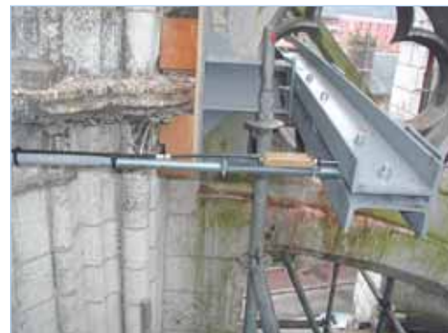
La Société LANFRY, chargée des travaux de restauration a renforcé la nef par de nombreux tirants et bracons qui sont une sorte de corset de maintien de l'édifice pendant les travaux
