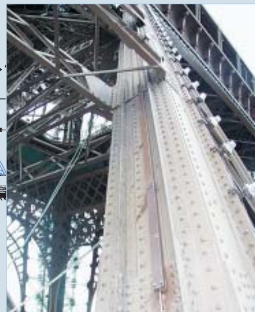
Corde Optique après capotage. Le tube de cuivre protège le câble de liaison optique
