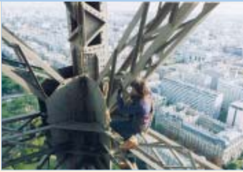
Corde optique sur arbalétrier d'angle, pilier Sud
