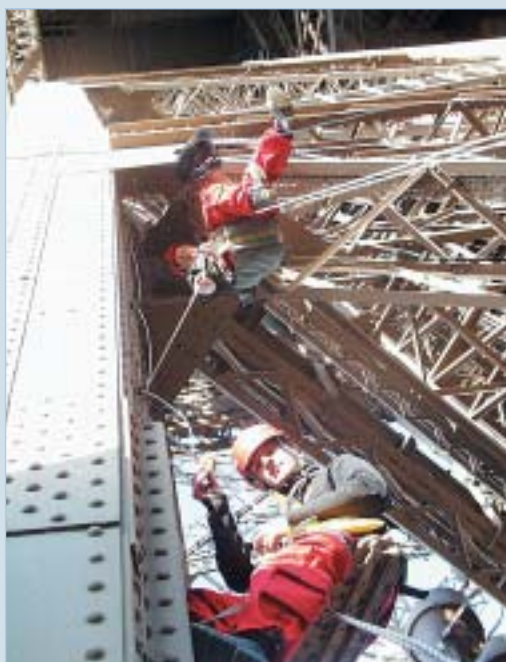
Corde Optique de 5 m lors de la pose
