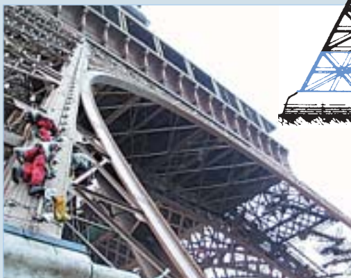
Montage sur panneau 1, pilier Sud
