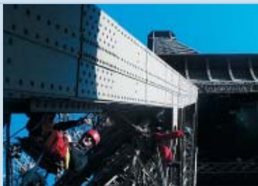
Installation effectuée par alpinistes spécialisés (Sté Versant)
