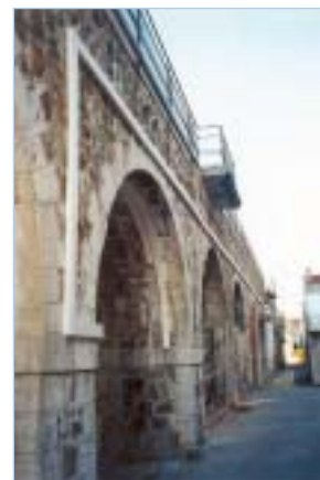
Cordes optiques en tympan sur 50 m après installation
