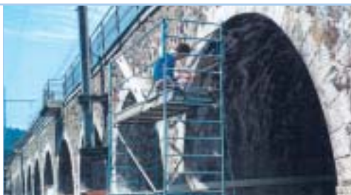
Pose des cordes optiques, juin 1994
