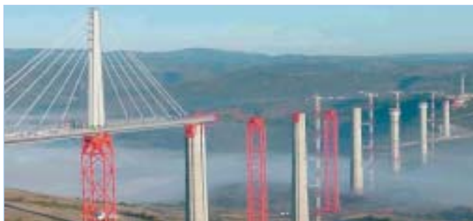
Le Viaduc de Millau
