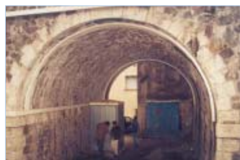
Installation des cordes optiques 8,9,10, et 11,12,13 en intrados de l'arche 28
